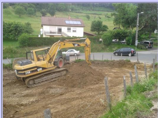
*Travaux réalisés :* Décapage et renforcement du nouveau profil du virage - captage des eaux de ruissellement - enfouissement des gaines pour éclairage public - jonction conduite d'eau potable.
